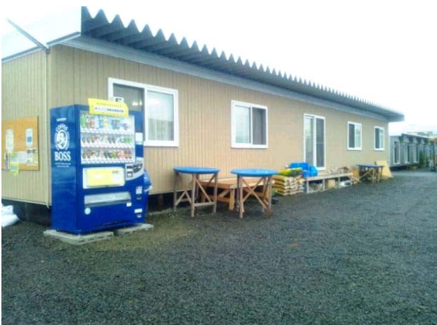
仮設住宅に設置された『「まちコミ」自動販売機』
